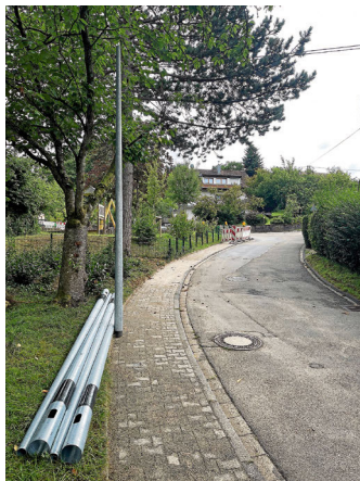
In Michelbach verschwinden im Zuge des Glasfaserausbaus die alten Seilleuchten.
