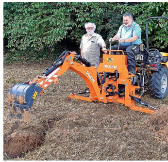
Der Heckbagger ist schon im Einsatz. Foto: Schorpp
