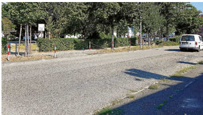
Im Rahmen der Fahrbahnsanierung wird auch eine Querungshilfe gebaut. Foto: StVw
