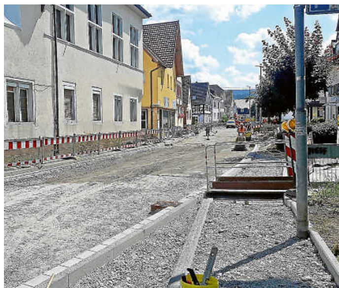
Alles vorbereitet für den Asphalt-Einbau.
