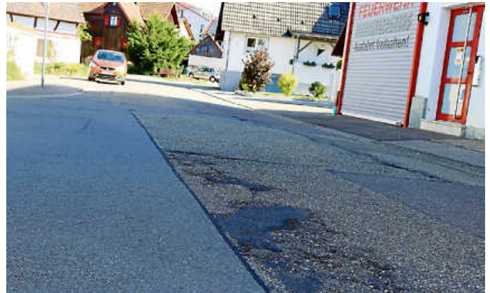
Der Fahrbahnbelag wird ab Herbst erneuert.
