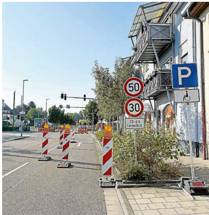
Halbseitige Sperrung mit Umleitung: Die August-Schneider-Straße wird in den nächsten Monaten umgebaut.
