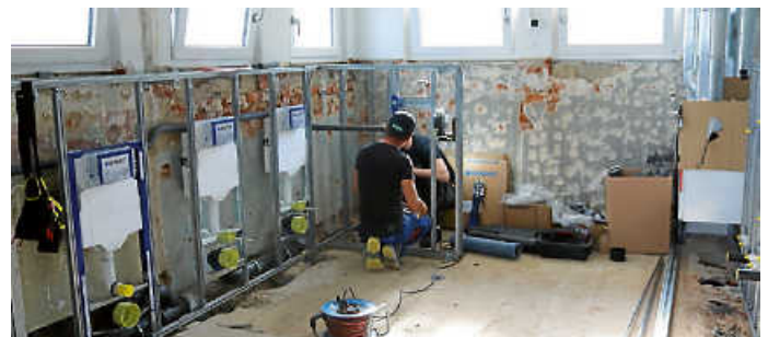
Zurück auf Rohbau: Im Bad-Bereich sind die alten Toiletten herausgerissen. Fotos: Stadt Gaggenau
