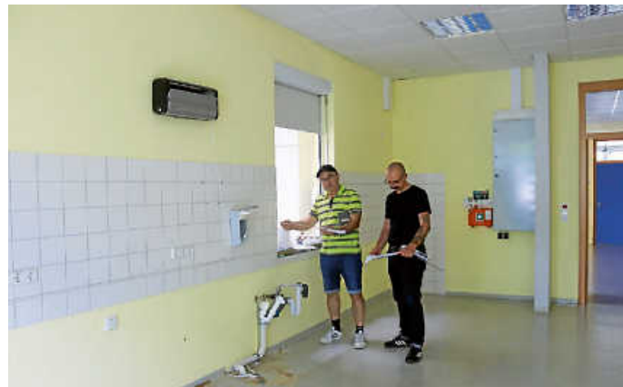
Die Mensa in der Hebelschule wird erneuert und an den Bedarf angepasst. Foto: Stadt Gaggenau
