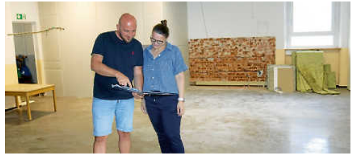
Marco Sehlinger von der Hochbauabteilung und Kindergartenleiterin Katarina Tomic auf der Baustelle.
