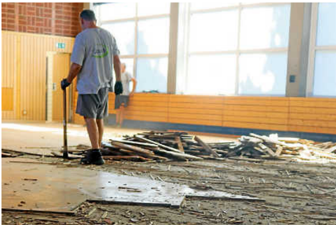
Eine Woche später ist der Boden herausgerissen.
