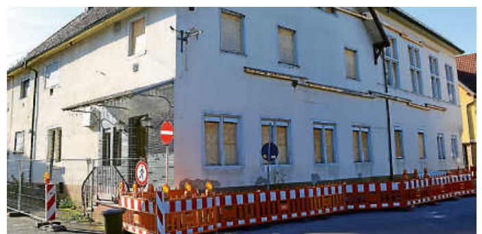
Die Straßensperre wird abgebaut.
