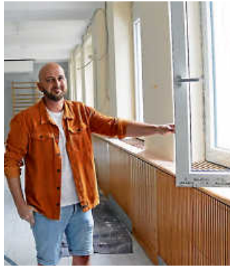
Die Fenster in der Turnhalle sind bereits eingebaut.
