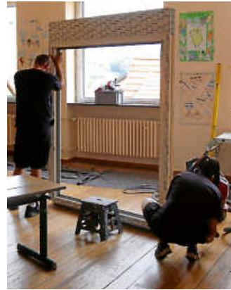
Fenstertausch in den Klassenzimmern.
