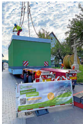
Die Verteilerstation in Michelbach wird abgeladen.
