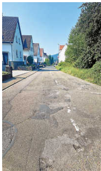
Die Sulzbacher Straße wird vom Landkreis saniert.
