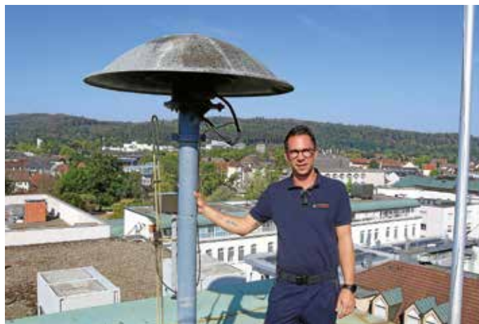
Feuerwehrkommandant Nicolas Faber zeigt eine der noch vorhandenen Sirenen auf dem Rathausdach. Foto: Stadt Gaggenau
