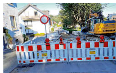
Abschluss der Arbeiten in der Brunnenwiesenstraße. Foto: Stadt Gaggenau
