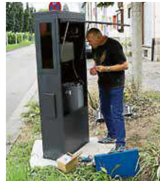
Installation einer Kamerasäule an der August-Schneider-Straße.
