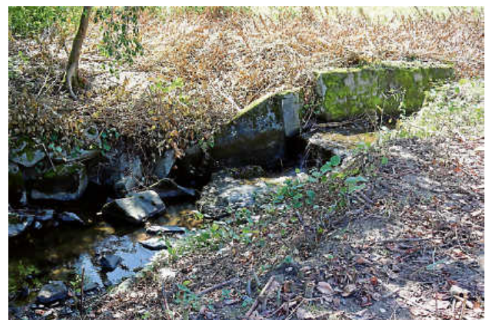
Dieses Wehr im Selbach wird naturnah umgebaut.
