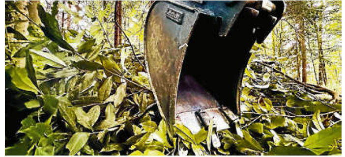
Mit dem Bagger im Kampf gegen den Kirschlorbeer im Stadtwald Gaggenau. Foto: V. Böhner/Forstamt LK Rastatt
