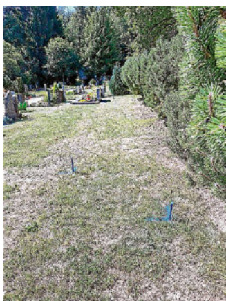
Vorbereitungen für die Rampe. Foto: Stadt Gaggau
