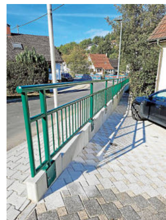
Die Stützwand ist fertig.
