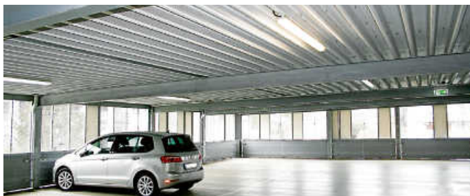
In der Hilda-Parkgarage wird energiesparende LED-Beleuchtung eingebaut.
