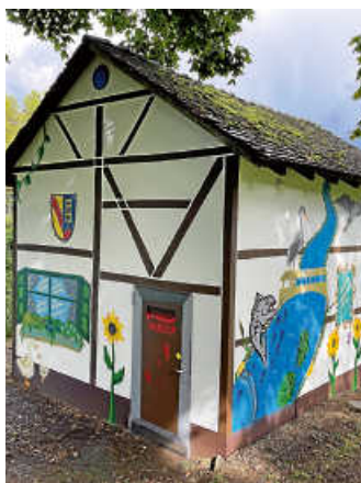
Gewollte Umgestaltung des Trafohäuschens in Bad Rotenfels.
