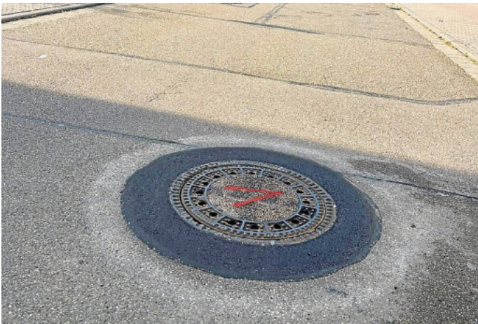
Jetzt klappert nichts mehr: Der Schacht wurde repariert.
