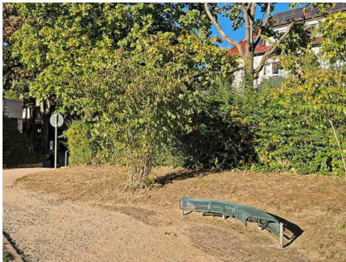
Hier soll der neue Aufzug errichtet werden. Foto: Stadt Gaggenau
