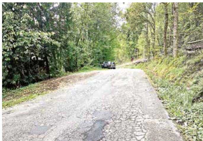
Ein Teilstück der Straße zum Waldseebad wird verbreitert.
