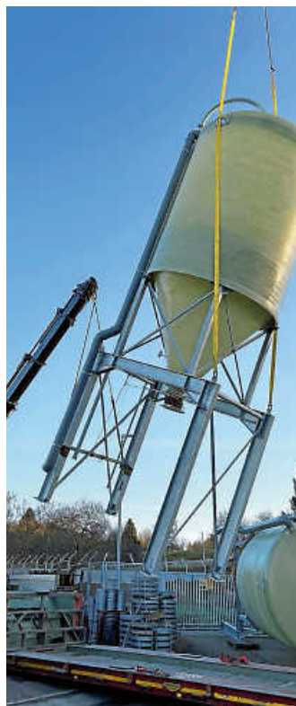
Eines der zwei neuen Silos wird aufgestellt.
