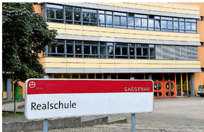
Die Sanierung und Erweiterung der Realschule ist das größte Bauprojekt in den nächsten Jahren. Foto: Stadt Gaggenau
