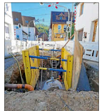
Die Kanalsanierung läuft auf vollen Touren.
