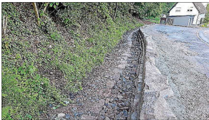
Die fertige Bachstrecke.
