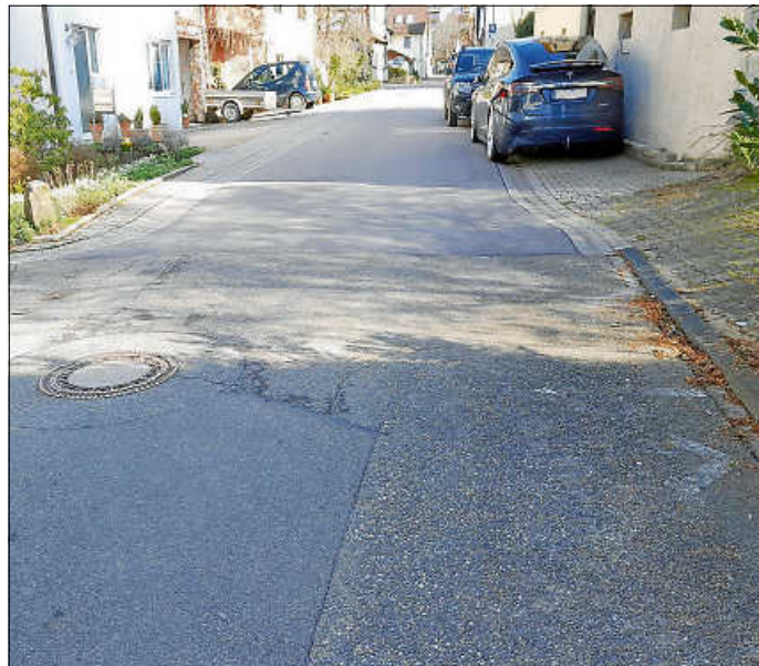
Die Sanierung der Dorfstraße geht in die nächste Phase..
