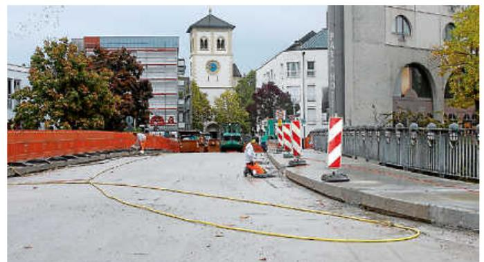
*Die alte Abdichtung des Fahrbahnbelags auf der Brücke wurde entfernt. Fotos: StVw*
