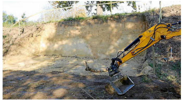
Ein Bagger legt die Lösswand frei. Hier entsteht Lebensraum für seltene Arten. Foto: Stadt Gaggenau
