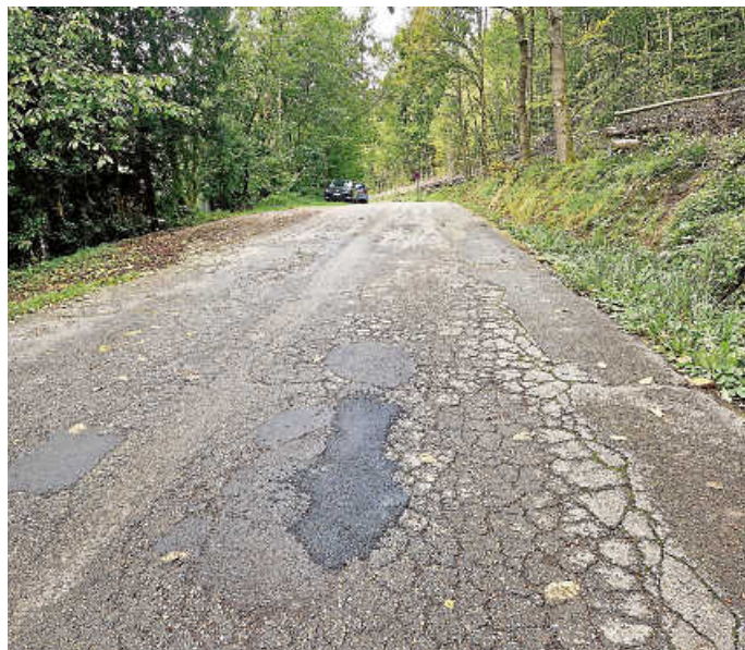
Die Arbeiten an der Waldstraße beginnen bald. Foto: Stadt Gaggenau
