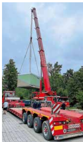
Am Freitag, 4. November, wird in Bad Rotenfels ein Technikgebäude für Glasfaserversorgung errichtet.
