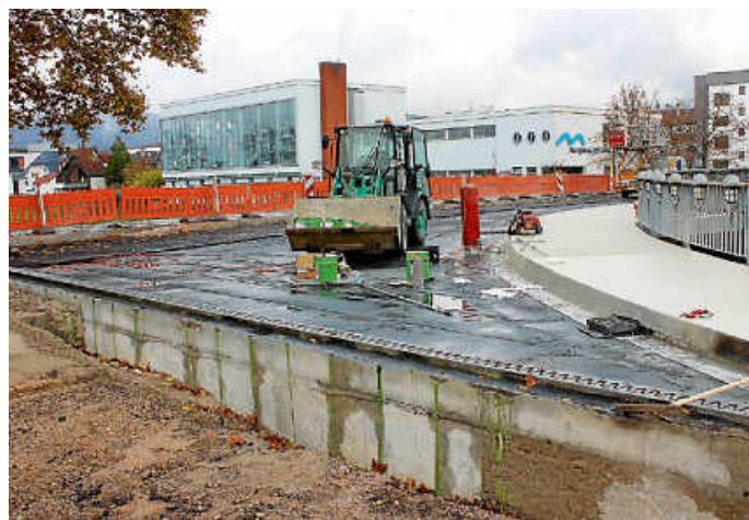
Die Arbeiten an der Konrad-Adenauer-Brücke sind trotz des schlechten Wetters im Zeitplan. Fotos: StVw
