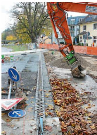
Die Überquerungshilfen vor der Brücke werden umgestaltet.
