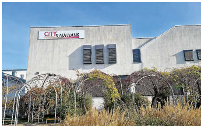
Wie geht es mit dem Gebäude weiter? Foto: Stadt Gaggenau
