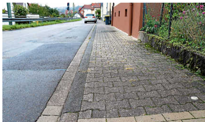
Am Montag beginnen die Arbeiten zur Kanalsanierung.
