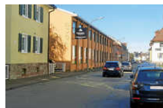
Fahrbahn und Gehweg werden erneuert. Foto: Stadt Gaggenau
