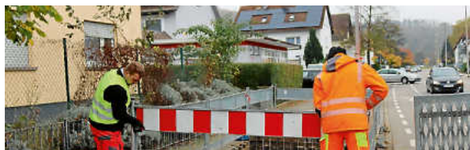
Vorbereitungen für die neuen Bäume in der Bismarckstraße.
