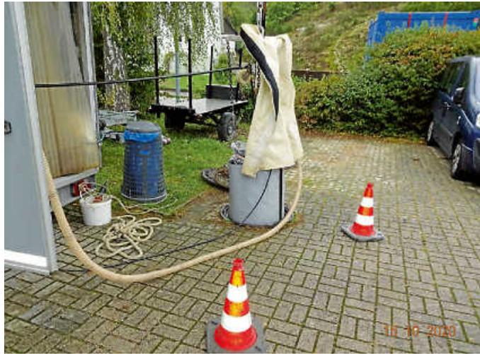
*Kostengünstiges und effizientes Sanieren per Schlauchlinerverfahren. Foto: Abwasserverband*
