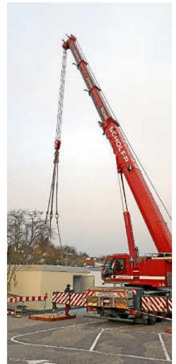
Anlieferung Technikgebäude an Berliner Straße.
