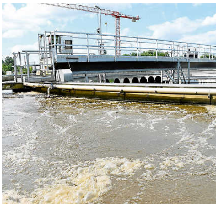
Blick ins Klärwerk.
