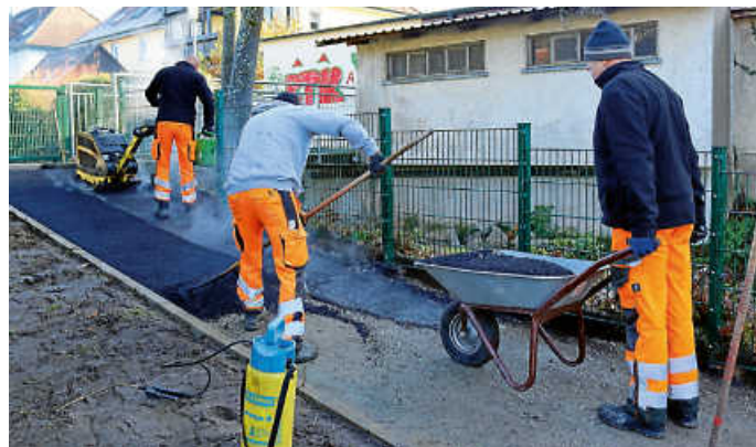
Mit Heißasphalt wird am Spielplatz im Wiesenweg gearbeitet.
