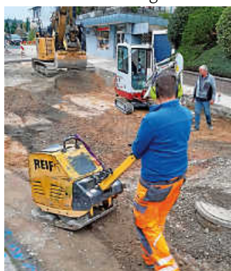
An der Merkurstraße wird auf Hochtouren gearbeitet.
