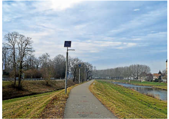
Am Bad-Steg gibt es derzeit Solarleuchten. Foto: Stadt Gaggenau
