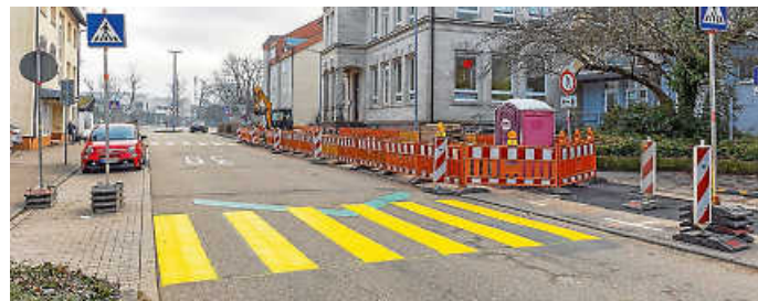
Ersatzfußstreifen in der Schulstraße. Foto: Stadtwerke Gaggenau
