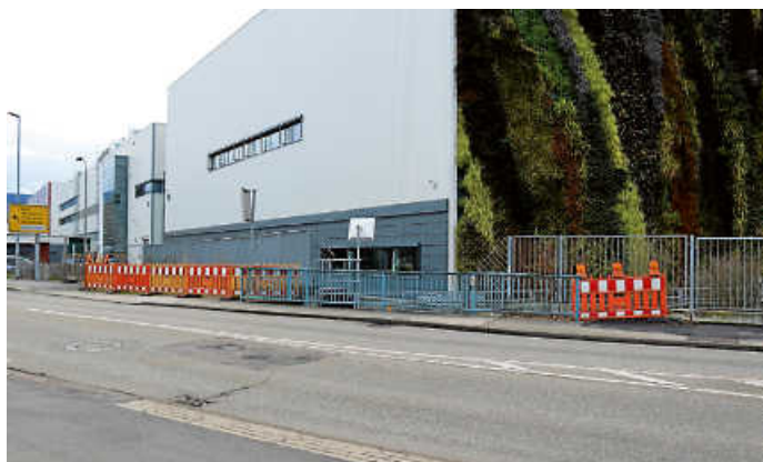
Letzter Bauabschnitt der Radwegerweiterung beginnt im Februar.
