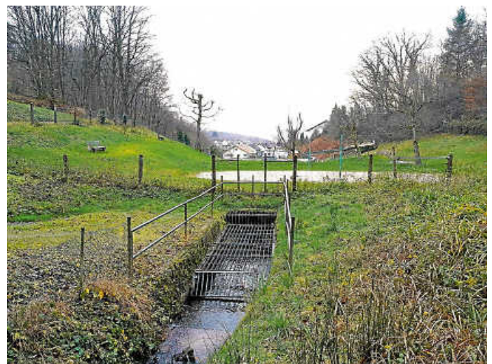
Die Sulzbachverdolung wird vergrößert, damit größere Wassermengen abfließen können. Foto: Stadt Gaggenau
