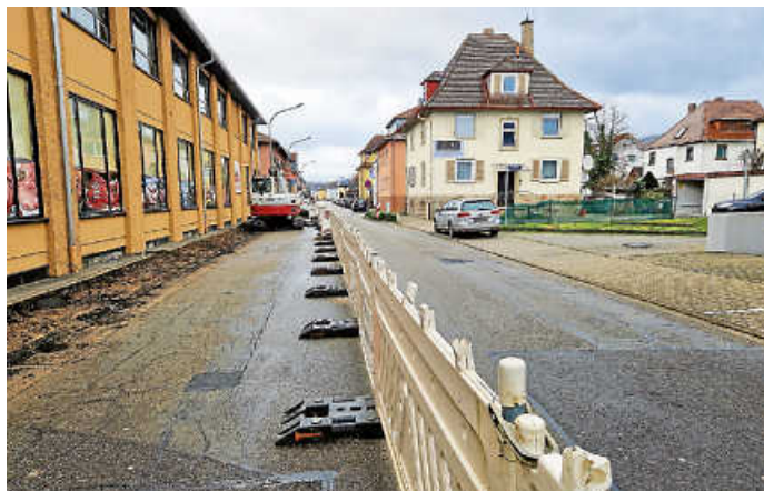
Gehwegsanierung in der Luisenstraße. Foto: Stadt Gaggenau
