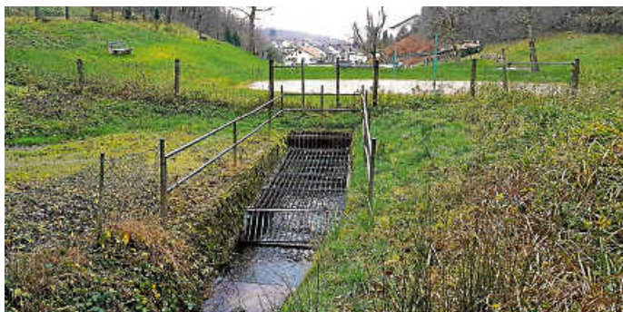
Dieser Einlauf des Sulzbachs am Bernsteinbad ist zu klein, um Hochwasser standzuhalten. Er muss deshalb vergrößert werden.
