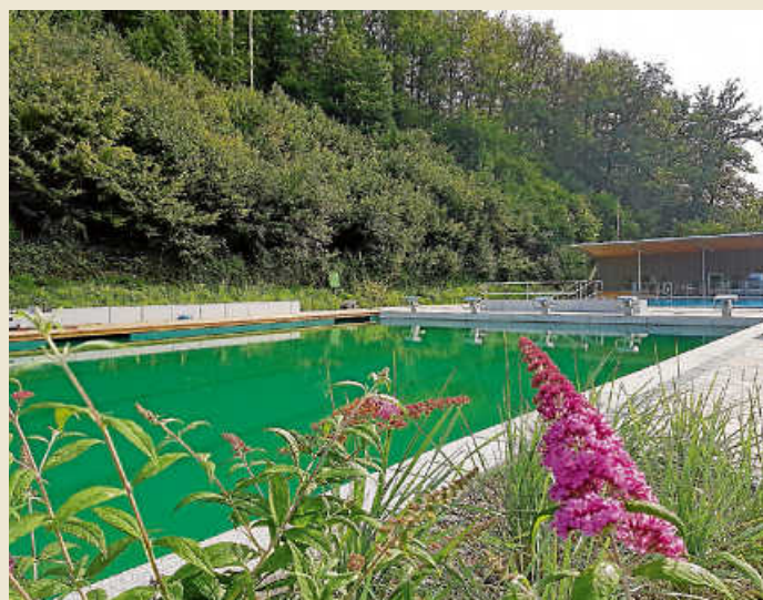
Das frisch sanierte Waldseebad wird im Mai 2022 eröffnet.
