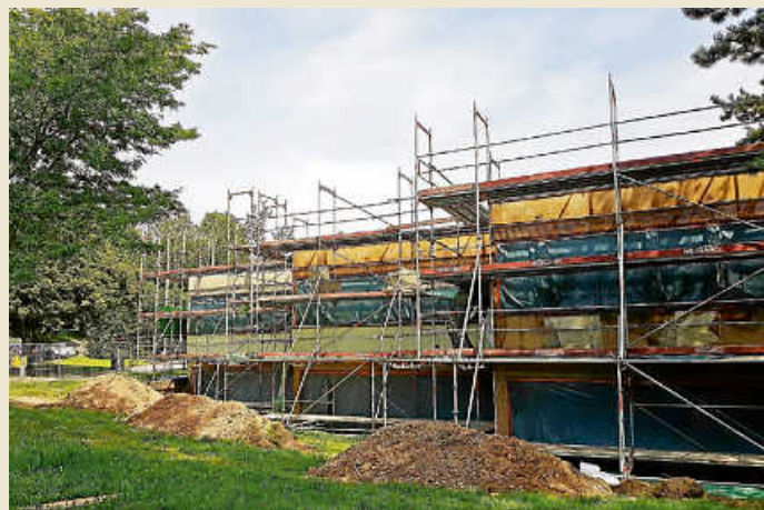
Der Pavillon des Goethe-Gymnasiums wurde saniert.
