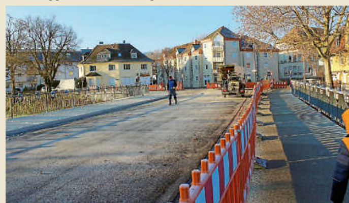
Seit Ende November ist die Konrad-Adenauer-Brücke wieder befahrbar.
