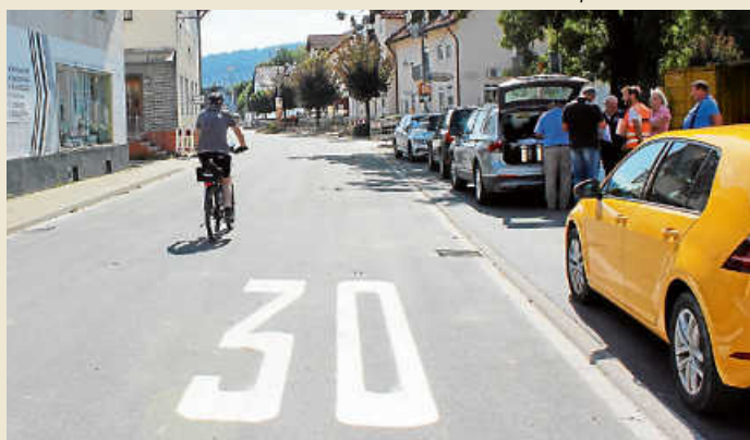
Kanal- und Straßenarbeiten in Hörden.
