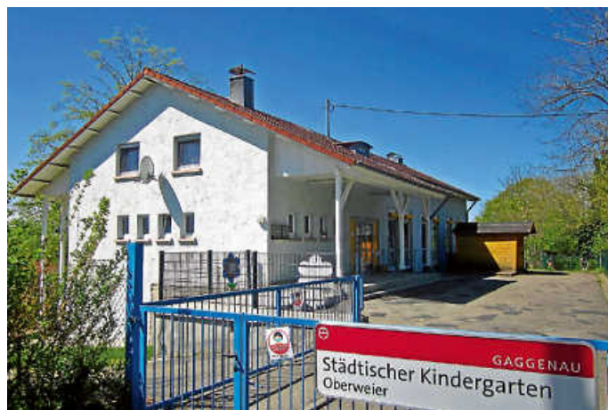
Auch der Kindergarten in Oberweier erhält raumlufthtechnische Anlagen. Foto: StVw
