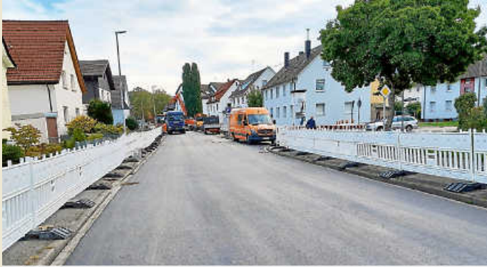
Straßensanierungen in Ottenau mit Querungshilfe zum Spielplatz.
