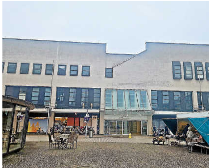
Im Cityhaus haben die Sanierungsarbeiten begonnen.
