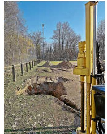
Für den Stromanschluss wird mittels einer Spülbohrung unter der B462 eine Anbindung geschaffen. Foto: StVw
