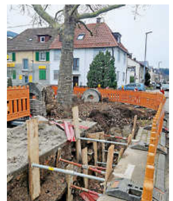
Fernwärme-Ausbau sorgt für Sperrung der Humpertstraße
