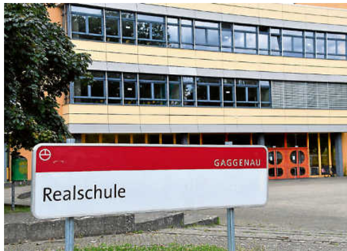
Die Sanierung und Erweiterung der Realschule verzögert sich.
