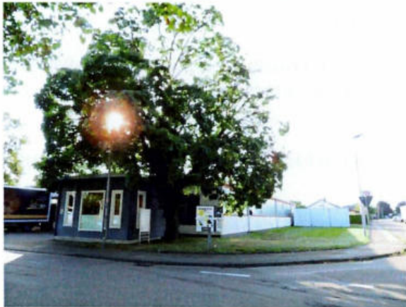
Blick nach Südosten auf das Grundstück Franz-Grötz-Str. 2b
