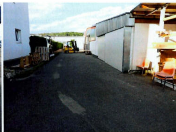
Südöstliche Rückseite der Gebäude
