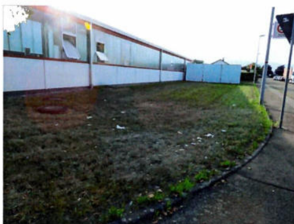
Bestandsgebäude, Container und Grünfläche an der Mercedesstraße
