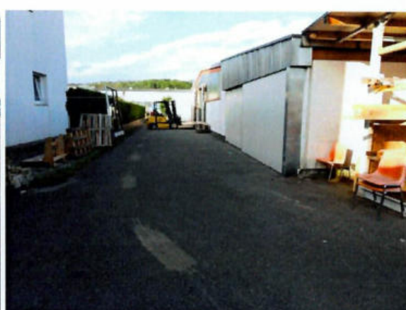
Südöstliche Rückseite der Gebäude
