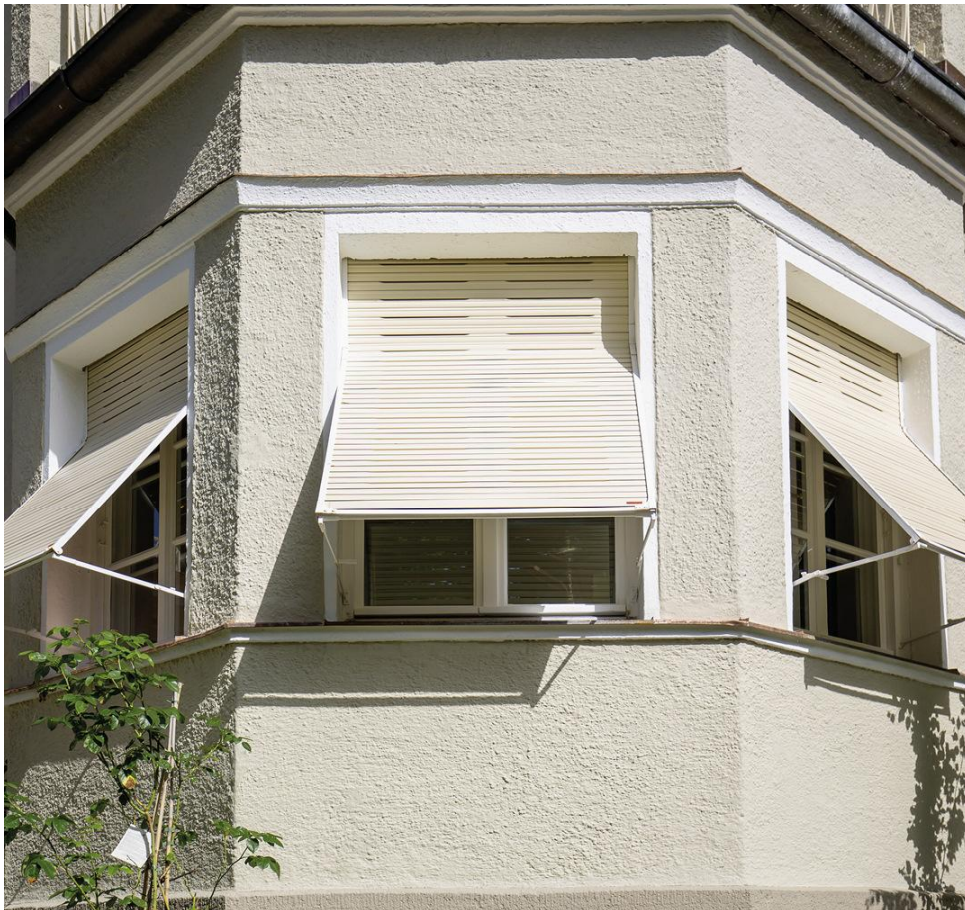
Beispiel für einen gut integrierten Ausstellrollladen mit verdecktem Rollladenkasten. © Foto: Heydebreck
