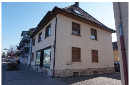
Abbildung 41: Gebäude mit Leerstand in der August-Schneider-Straße 18 (Quelle: WHS, 2025)
