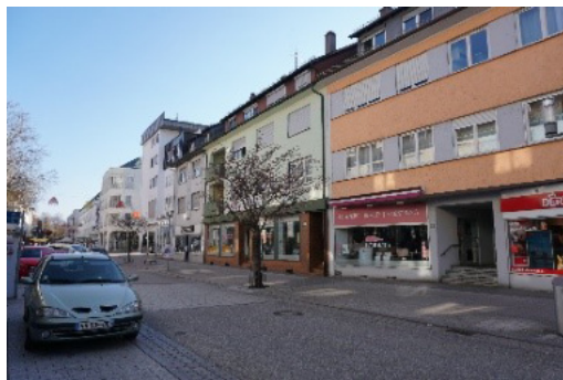
Abbildung 40: Gebäude mit Modernisierungsbedarf in der Hauptstraße 22 - 26 (Quelle: WHS, 2025)
