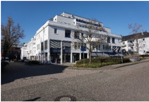
Abbildung 26: Wohn- und Geschäftshaus mit ärztlicher Versorgung in der Rommelstraße (Quelle: WHS, 2025)
