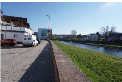
Abbildung 58: Hochwasserschutz entlang der Murg (Quelle: WHS, 2025)
