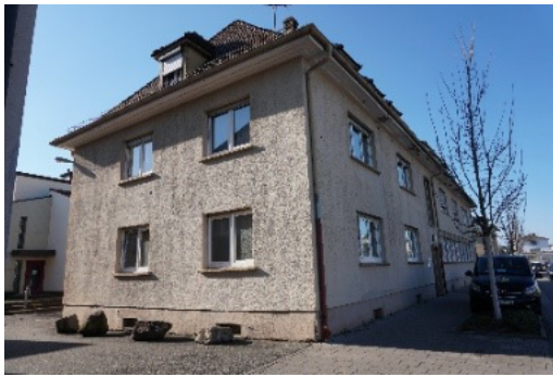
Abbildung 38: Gebäude mit erheblichen substanziellen Mängeln in der August-Schneider-Straße 17 (Quelle: WHS, 2025)
