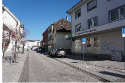
Abbildung 23: Straßenbegleitende Stellplätze in der Bahnhofstraße mit angrenzenden Wohn- und Geschäftsgebäuden (Quelle: WHS, 2025)
