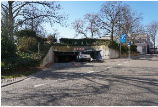
Abbildung 22: Zufahrt zur Tiefgarage Murgufer (Quelle: WHS, 2025)
