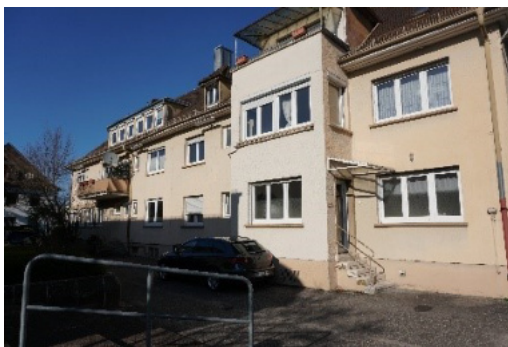
Abbildung 32: In die Jahre gekommenes Wohn- und Geschäftsgebäude in der August-Schneider-Straße 17 (Quelle: WHS, 2025)
